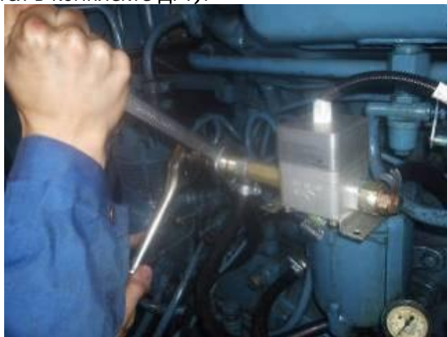
Рис. 13 Подключение обратной магистрали ко выходу ДРТ
